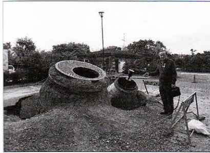
浦安市内の公園駐車場で1メートル以上も地面から突き出したマンホール。外山さんは震災の脅威を忘れないためにもモニュメントとして残すべきだと語った
